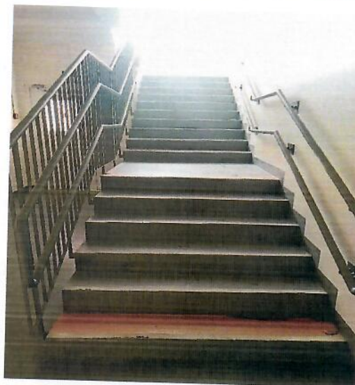
Фото 20 Пути движения внутри здания (центральная лестница)
